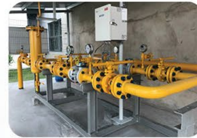
26 Trạm giảm áp (PRU) trải rộng khắp các KCN cả nước
