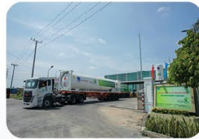
Trạm cấp khí LNG tại KCN Thuận Đạo, Long An
