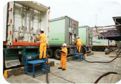
Nhà máy nén khí
