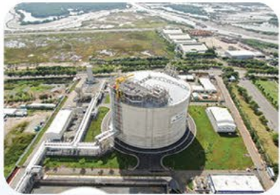
Kho LNG Thị Vải - Kho cảng LNG đầu tiên tại Việt Nam
